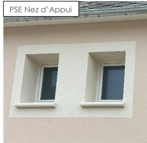
**PSE Appui MSEA** est une gamme d'appuis de fenêtre légers spécialement adaptés en façades.
